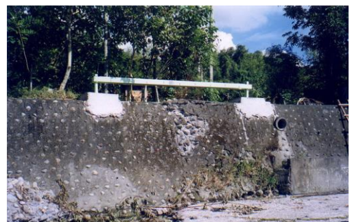
圖一、架設在池上斷層地表破裂帶之「潛變儀」，紀錄每日斷層之變位，精度可
