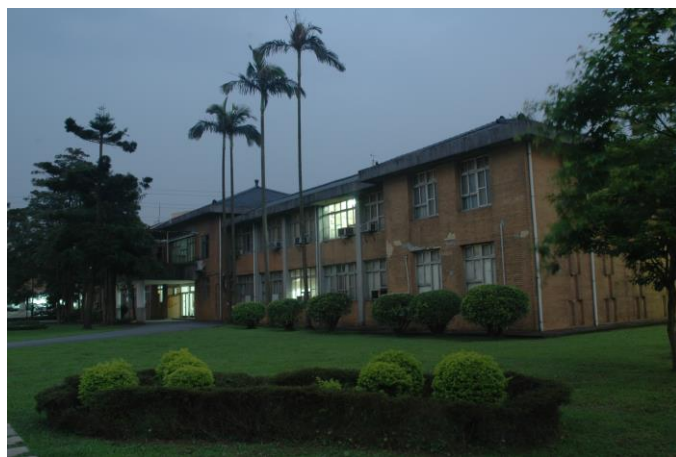
圖二：異時對，黃樓夜景，為誰浩歎？這棟見證中研院南港院區早期發展史的建物，歷經動植物所、文哲所、台史所、生物多樣中心（借用部份）數度更迭，今年間將被全面拆除改建。東坡大仙天上有知，豈能不為這重現他千古
