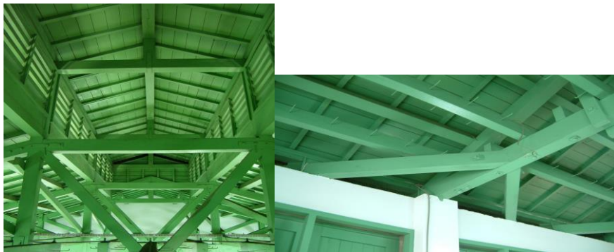
◀圖 2 屋頂桁架結構。(1)中央。(2)牆邊。(黃皎怡攝影)
