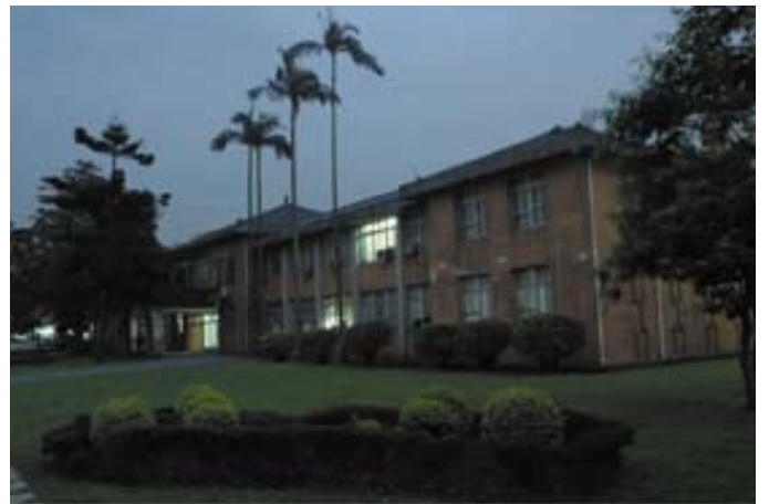
圖二：異時對，黃樓夜景，為誰浩歎？這棟見證中研院南港院區早期發展史的建物，歷經動植物所、文哲所、台史所、生物多樣中心（借用部份）數度更迭，今年間將被全面拆除改建。東坡大仙天上知，豈能不為這重現他千古大夢的黃樓動容？
